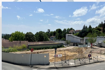
POINT 5 EXTENSION DE L'ÉCOLE Chemin de l'Écully
