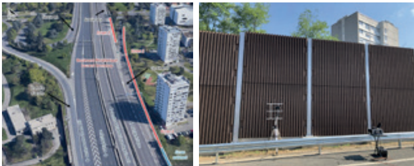
Photo réalisée par Sixense en septembre 2024 lors de la réception acoustique de l'écran
