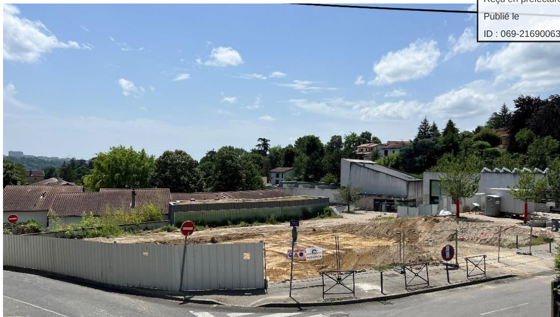
Travaux de terrassement à l'emplacement du futur restaurant scolaire, arrière-plan à droite, la Médiathèque - été 2024. D.R. Mairie de Collonges au Mont d'Or
